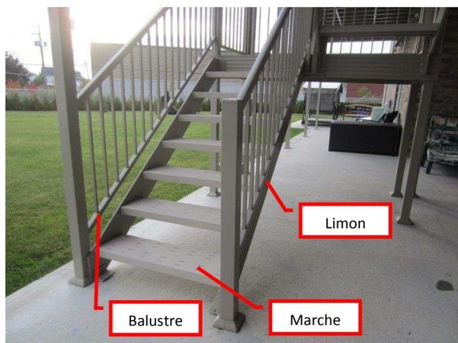
Les avantages des escaliers en aluminium sont nombreux : la résistance à la corrosion et les intempéries, une plus grande résistance mécanique et des composantes plus légères. Pour ces raisons, des rampes en aluminium sont aussi utilisées dans le domaine de la construction pour le périmètre extérieur de balcons, passerelles, escaliers et autres.
